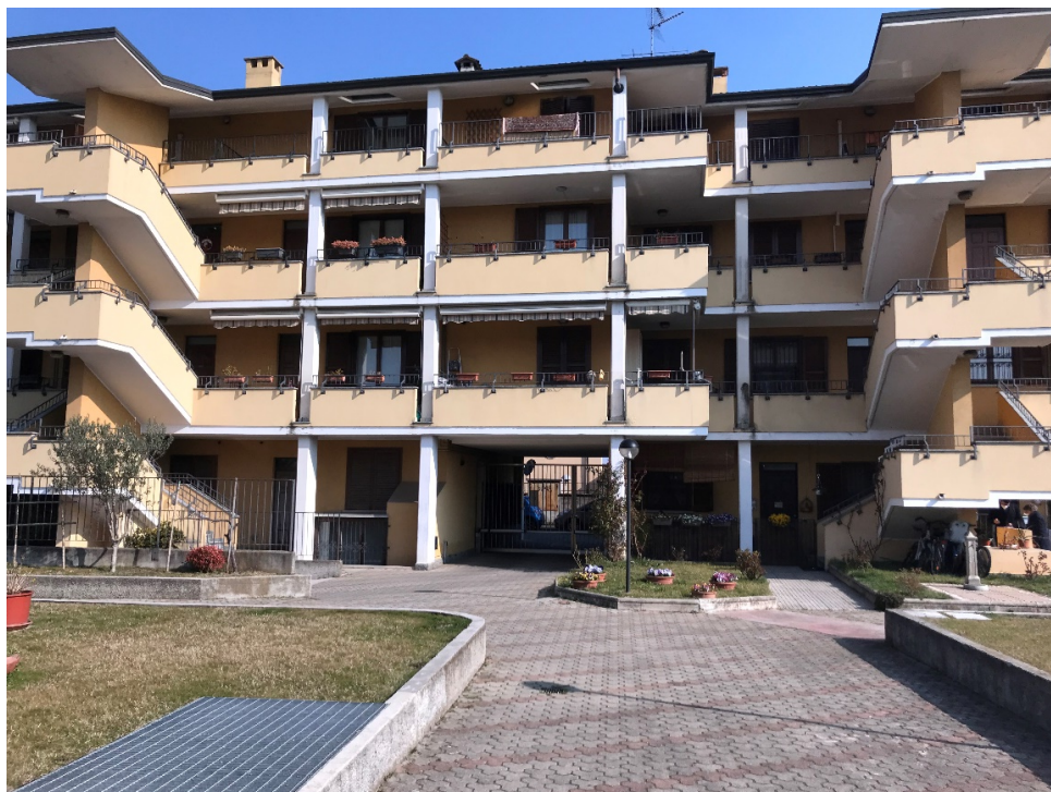
Foto n. 2: Prospetto su cortile interno.
